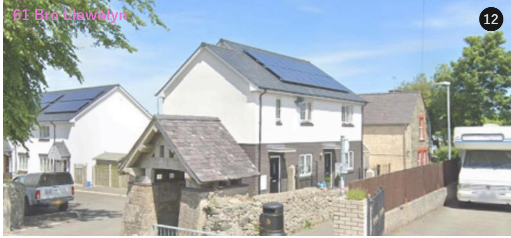
Brics llwyd tywyll, rendrad ail godiad, siliau brics, canopiâu drws, to llechi
